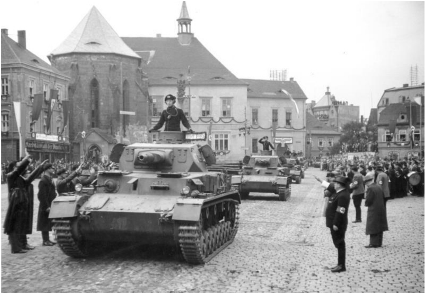
Panzer IV Ausf. A mit noch innenliegender Walzenblende und erkennbar vorgezogenem Fahrerker beim Einmarsch in das Sudetenland 1938
